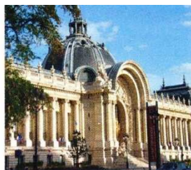
À Paris, vue de la façade du Petit Palais après restauration.
